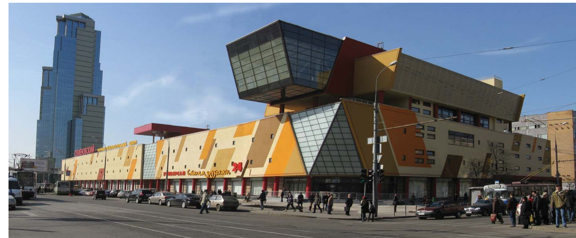
Торговый центр «Семеновский». г. Москва, Семеновская пл., д. 1. Год постройки: 2008 г. Авторы архитекторы: Кузьмин А.В., Надточий Г.П., Науменко А.Н., Назиралиев А.М., Смирнов А.В., Яковлева Л.М.
