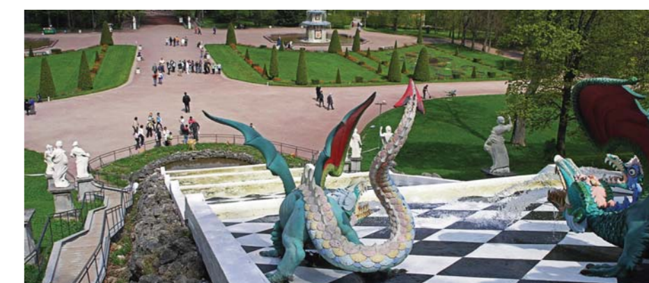
Реставрационный ремонт каскада
