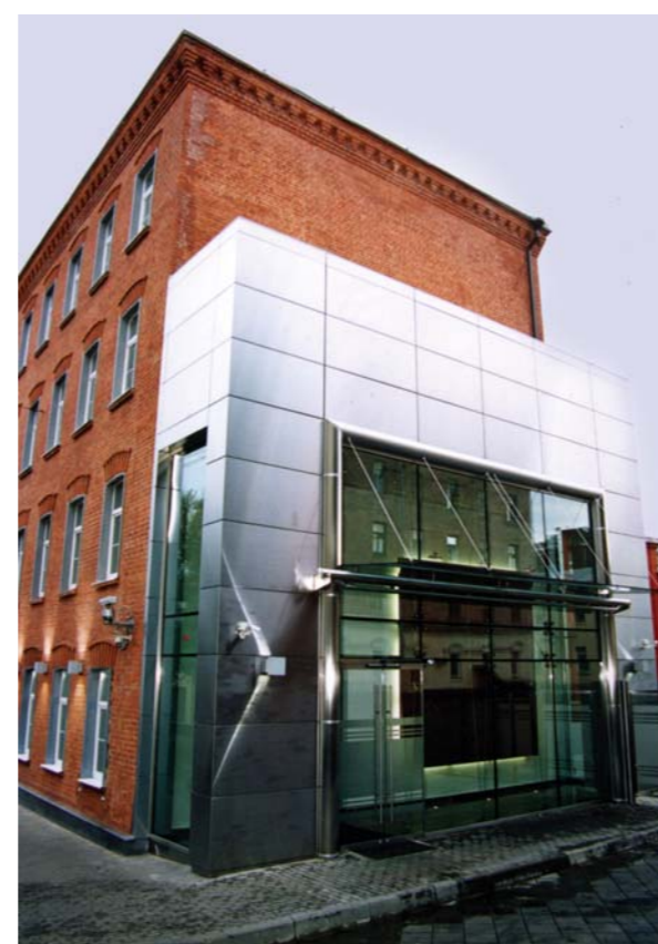
Реконструкция здания РБР, г. Москва, ул. Тимура Фрунзе
